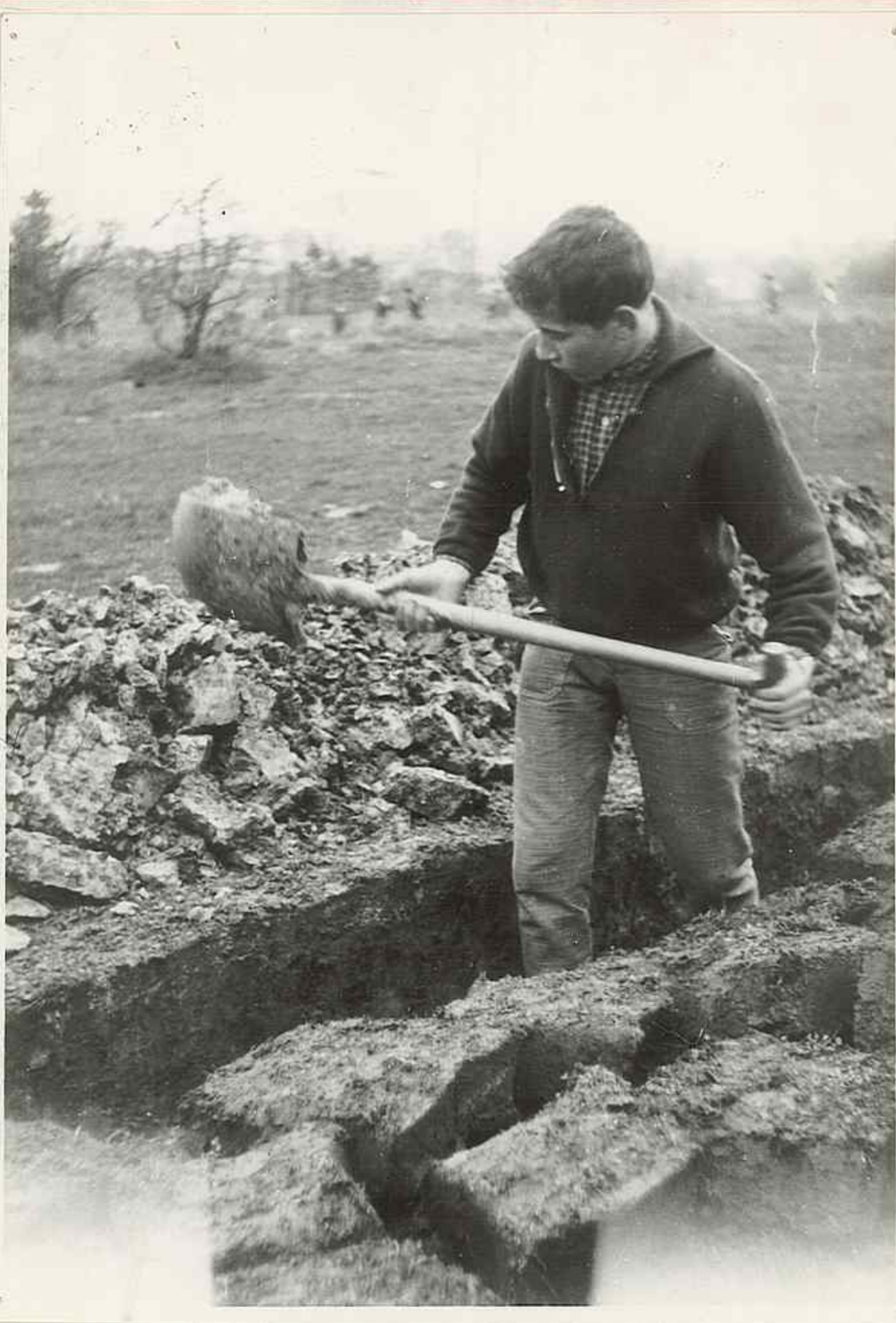
Žák IX. třídy Václav Erbert odpracoval mnoho hodin po vyučování při budování vodovodu na šk. pozemek
