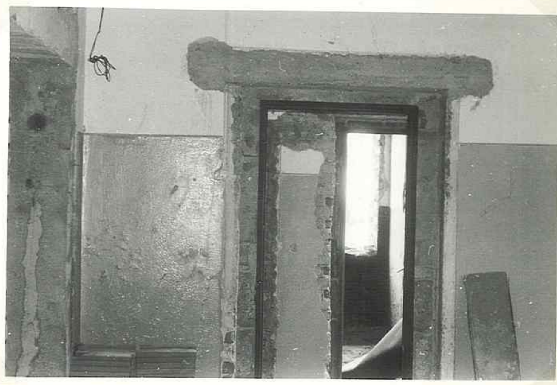
Vyzdění dveří v I. poschodí...
