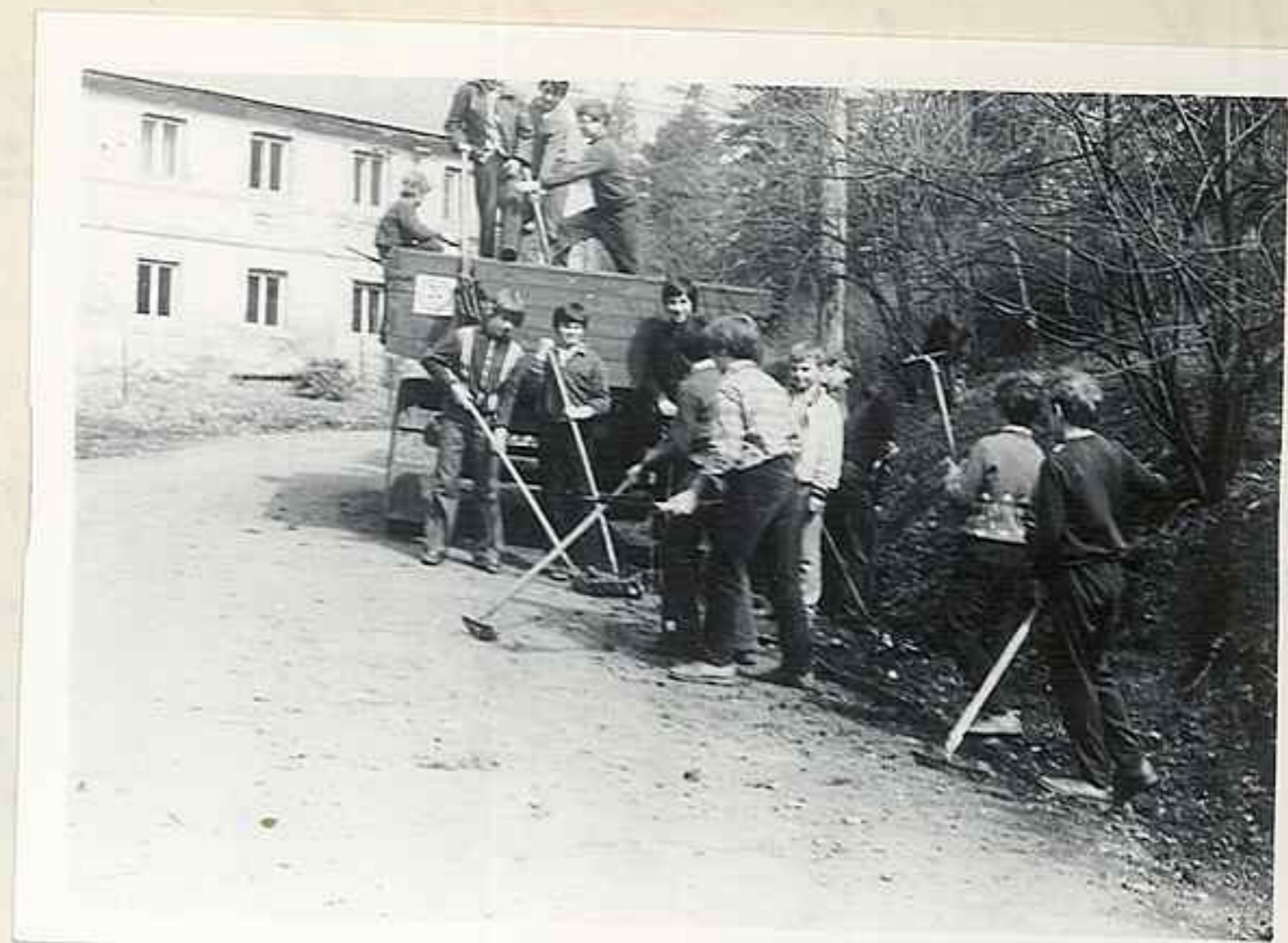
Úpravy kolem silnice, vedoucí ke škole.
