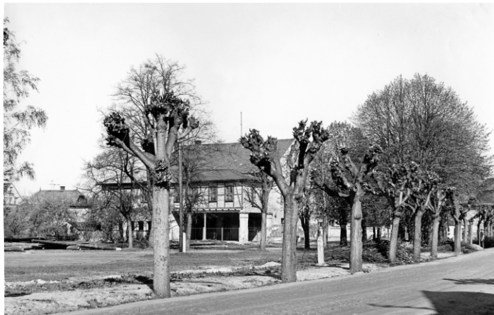
Restaurace před zbouráním
