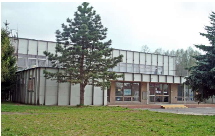
Tělocvična Spartak – duben 2011 – před rekonstrukcí
