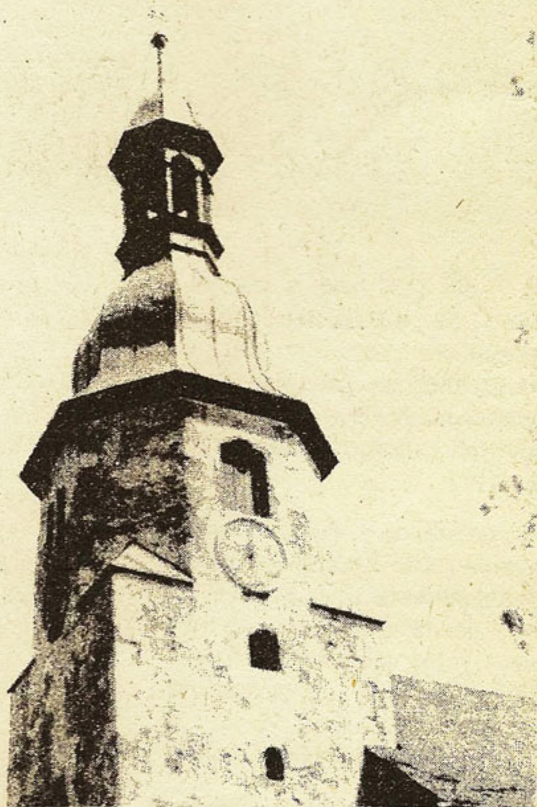
Současný stav věže vítkovského kostela. FOTO: L.Vydra
