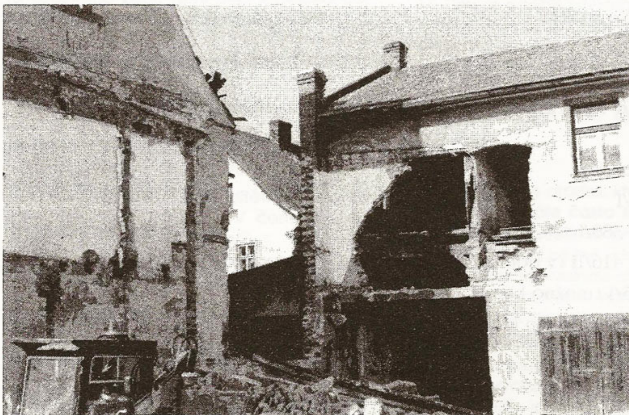
I toto je část budovy bývalého muzea, a to pouze v začátcích rekonstrukčních prací...
