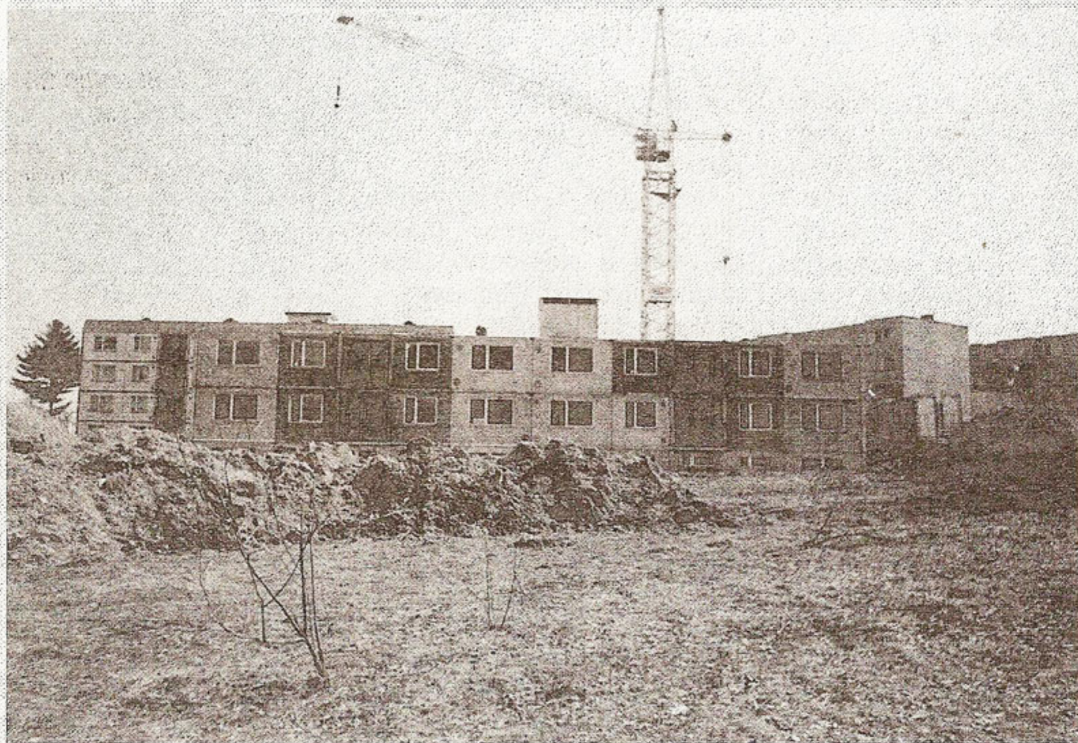
Stavba panelového domu na sídlišti Střelecký vrch.
