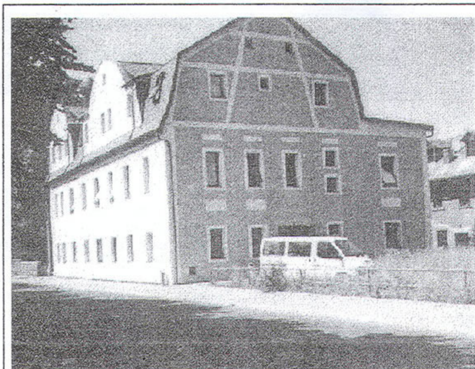
Zrekonstruovaný bytový dům čp. 103 v Nádražní ulici.
